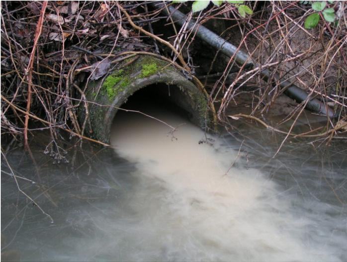
Figura 1. Vertido de colector de aguas lluvias al medio natural.
