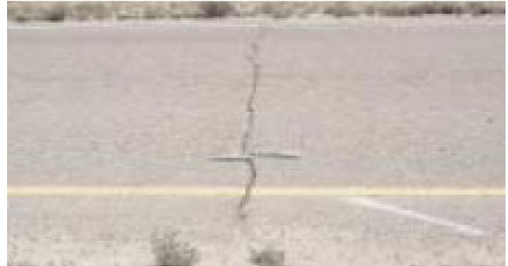
Figura 14. Fisuración transversal
