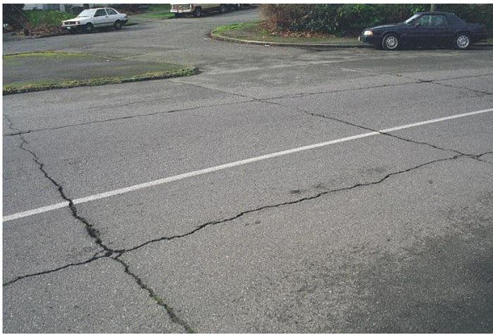
Figura 13. Fisuración por reflexión de juntas
