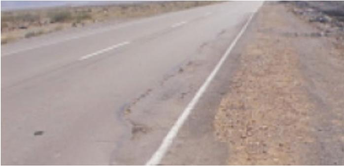
Figura 10. Fisuración de borde
