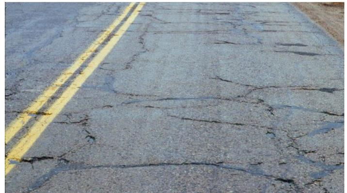
Figura 9. Fisuración en bloque Fuente: Pavement Interactive, Asphalt Pavement Guide
