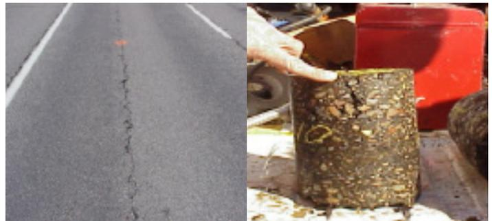
Figura 12. Fisuración longitudinal descendente- top down cracking
