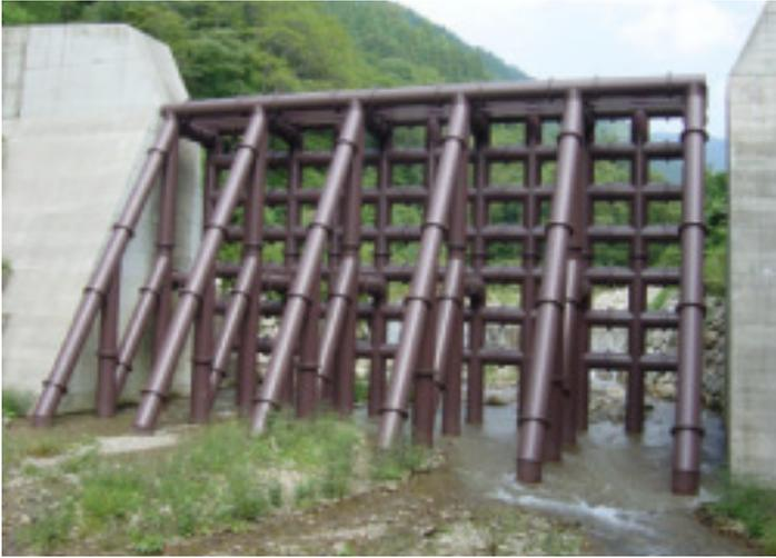
Figura 9. Presa SABO de tubos de acero, se usa como estructura extremo aguas abajo del torrente de arrastre. Su apertura es pequeña, casi igual al diámetro de las rocas transportadas en la parte delantera de flujo de escombro. (Fuente: Mizuyama, T.; 2008).
