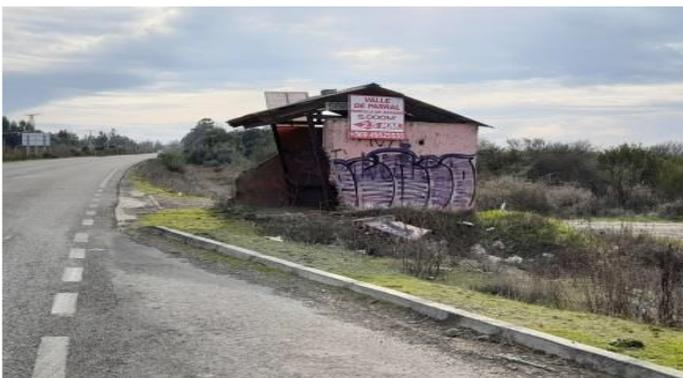
Figura 4. Soleras delimitando una bahía de estacionamiento.
